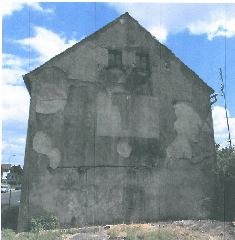
Zdjęcie nr 5 – Elewacja boczna zachodnia
