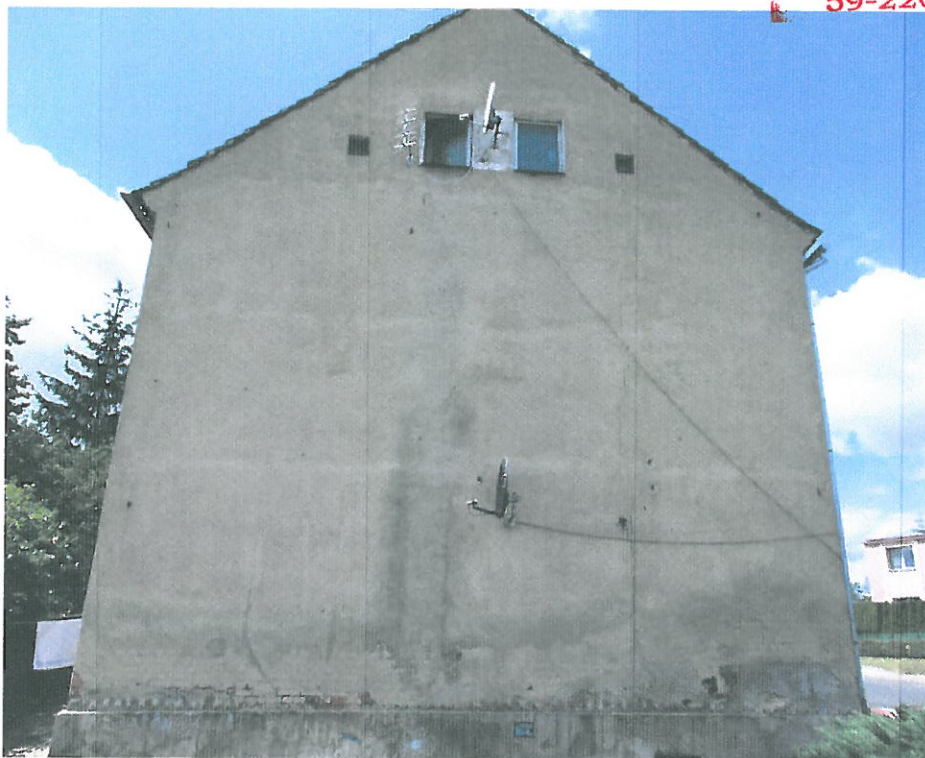
Zdjęcie nr 5 – Elewacja boczna wschodnia
