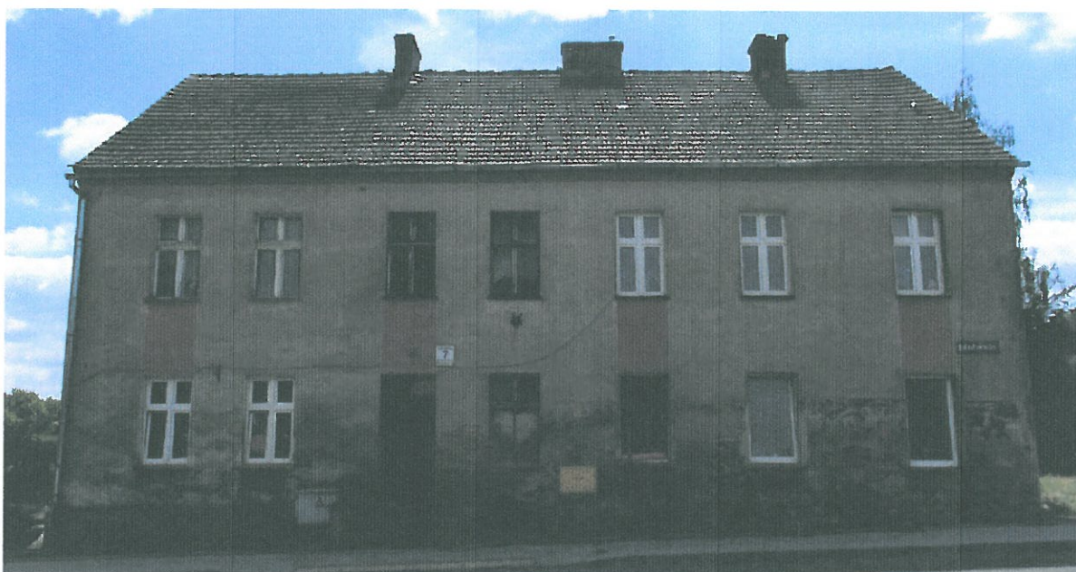
Zdjęcie nr 1 – Elewacja frontowa
