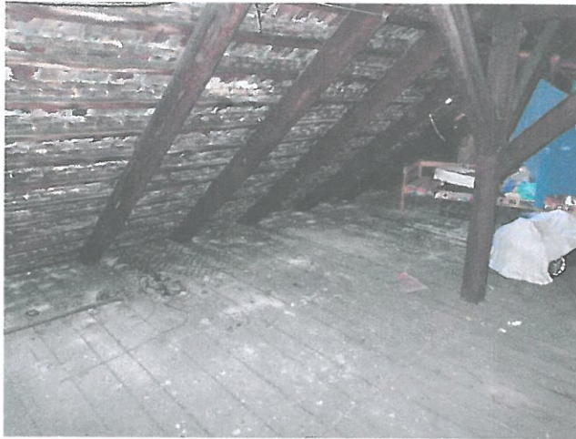
Konstrukcja dachu na górnym poziomie poddasza
