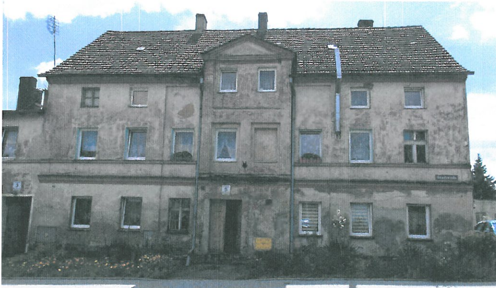
Zdjęcie nr 1 – Elewacja frontowa
