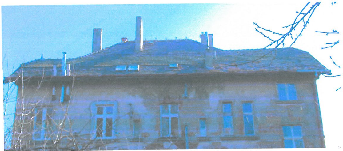
Zdjęcie nr 4 – Połąć dachu zachodnia
