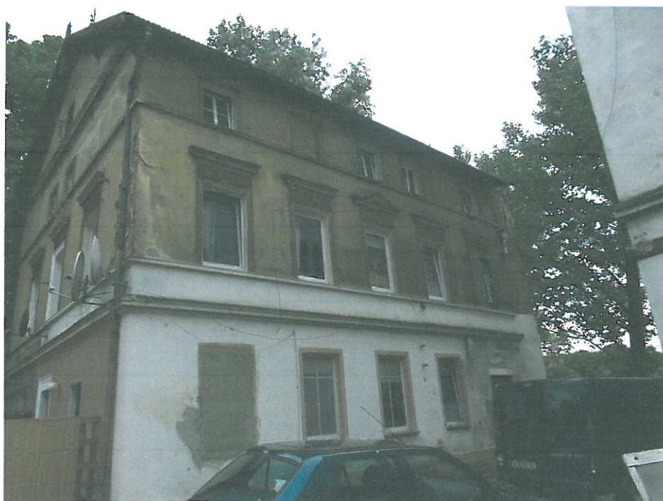
Zdjęcie nr 1 – Elewacja wschodnia
