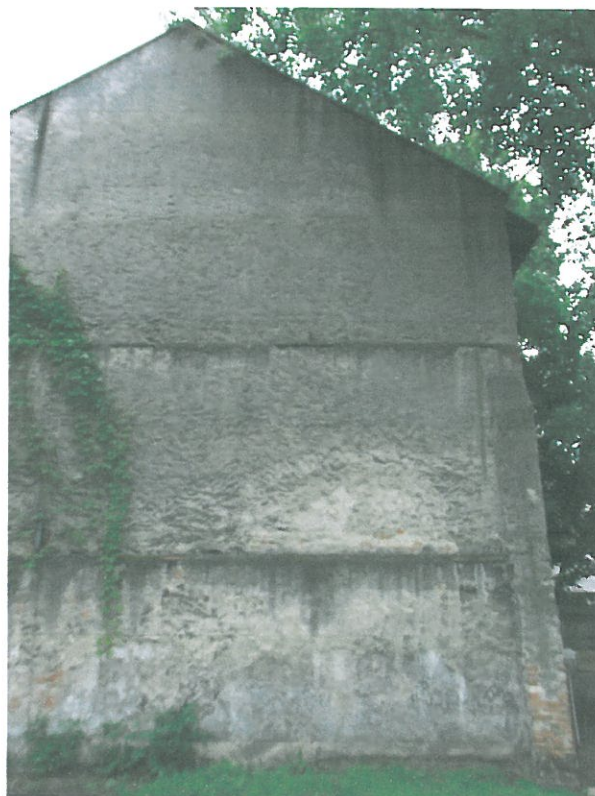
Zdjęcie nr 3 – Elewacja północna
