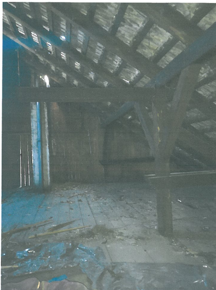
Zdjęcie nr 6 – Widok poddasza
