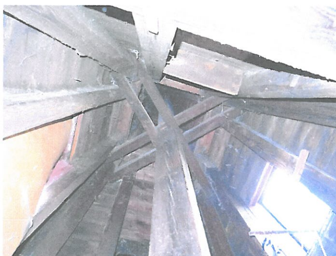
Widok konstrukcji dachu wieżyczki.
