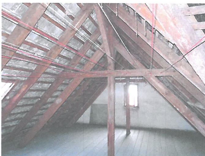
Widok konstrukcji dachu skrzydła lewego (zachodniego)
