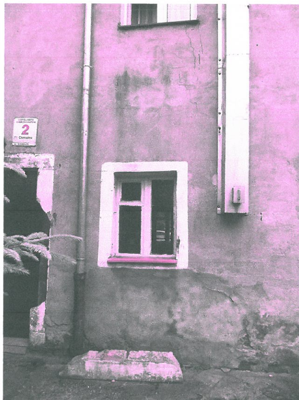
Zdjęcie nr 6 – Widoczne pęknięcia elewacji tylnej
