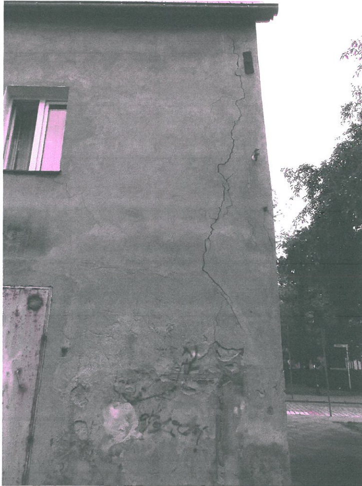
Zdjęcie nr 6 – Widoczne pęknięcia elewacji tylnej
