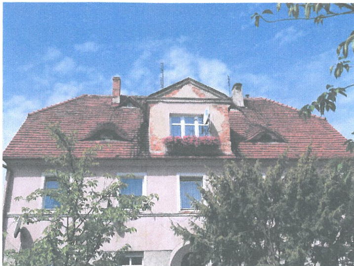
Widok frontowej połaci dachu.
