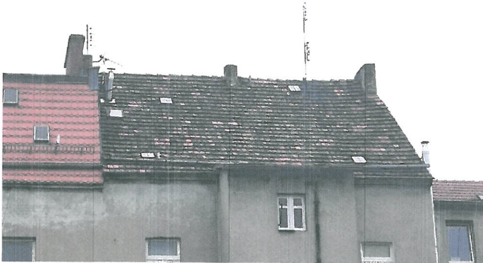
Zdjęcie nr 2 – Dach od strony podwórka
