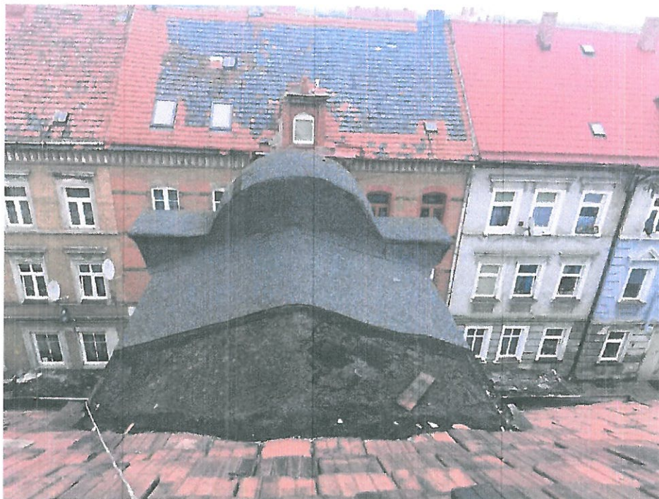
Zdjęcie nr 3 – Widok pokrycia lukarny
