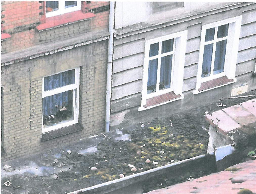
Zdjęcie nr 5 – Okap dachu
