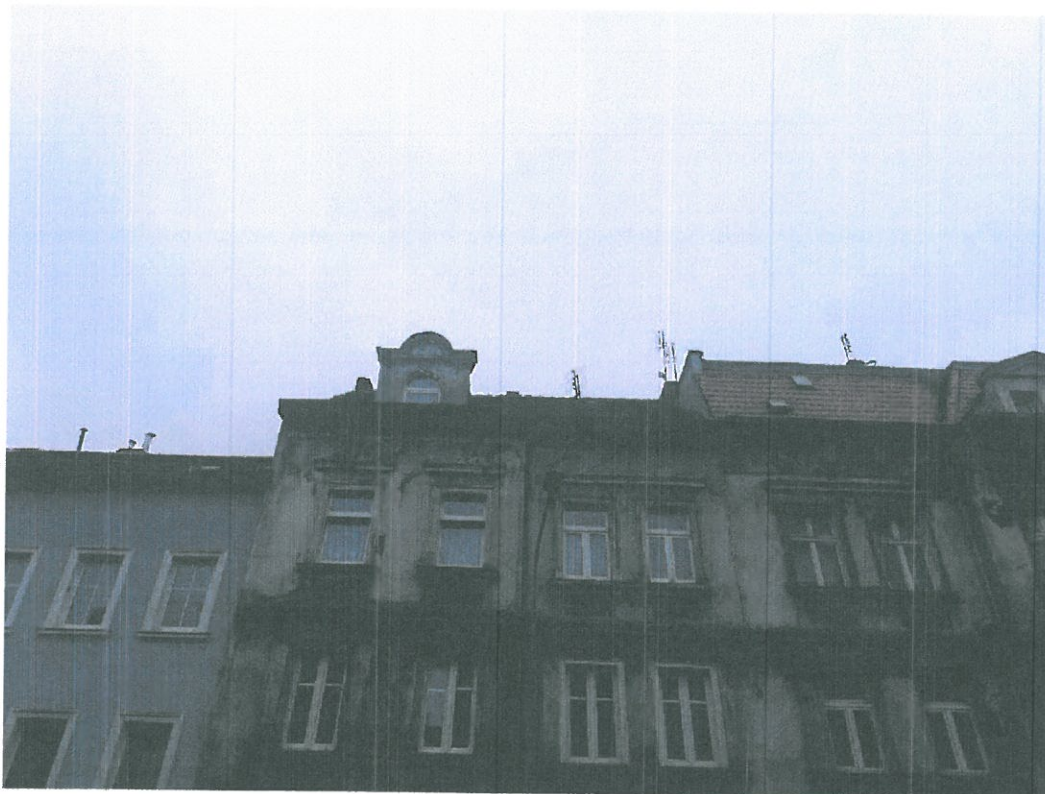
Zdjęcie nr 1 – Dach od strony ulicy
