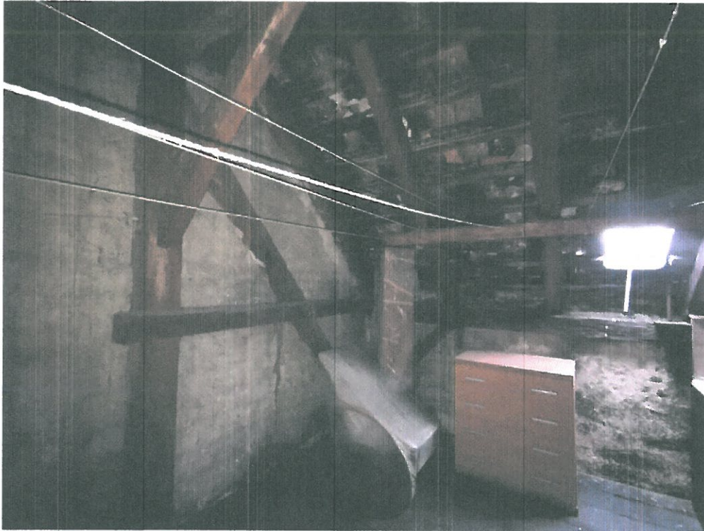
Zdjęcie nr 4 – Widok poddasza
