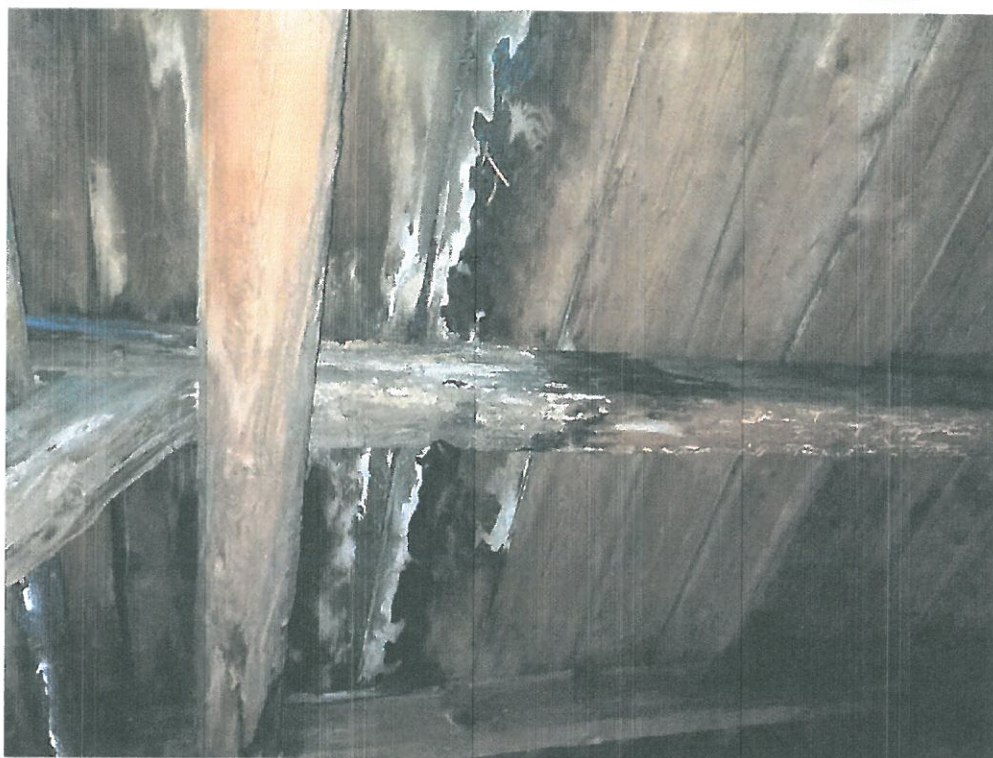
Zdjęcie nr 4 – Końcówka krokwi stropodachu
