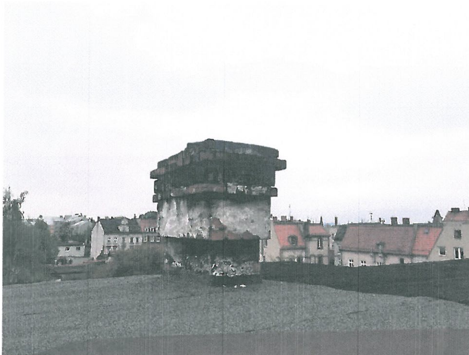
Zdjęcie nr 3 – Widok komina powyżej połaci
