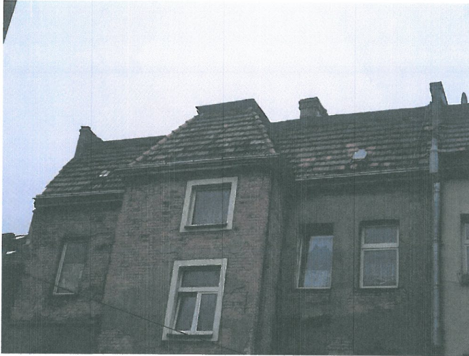
Zdjęcie nr 2 – Dach od strony podwórka
