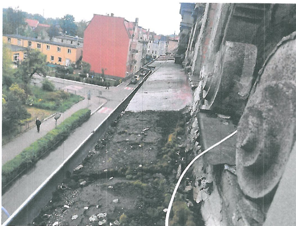
Zdjęcie nr 5 – Okap dachu
