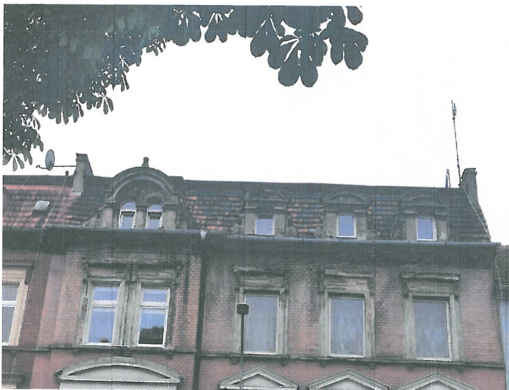
Zdjęcie nr 1 – Dach od strony ulicy
