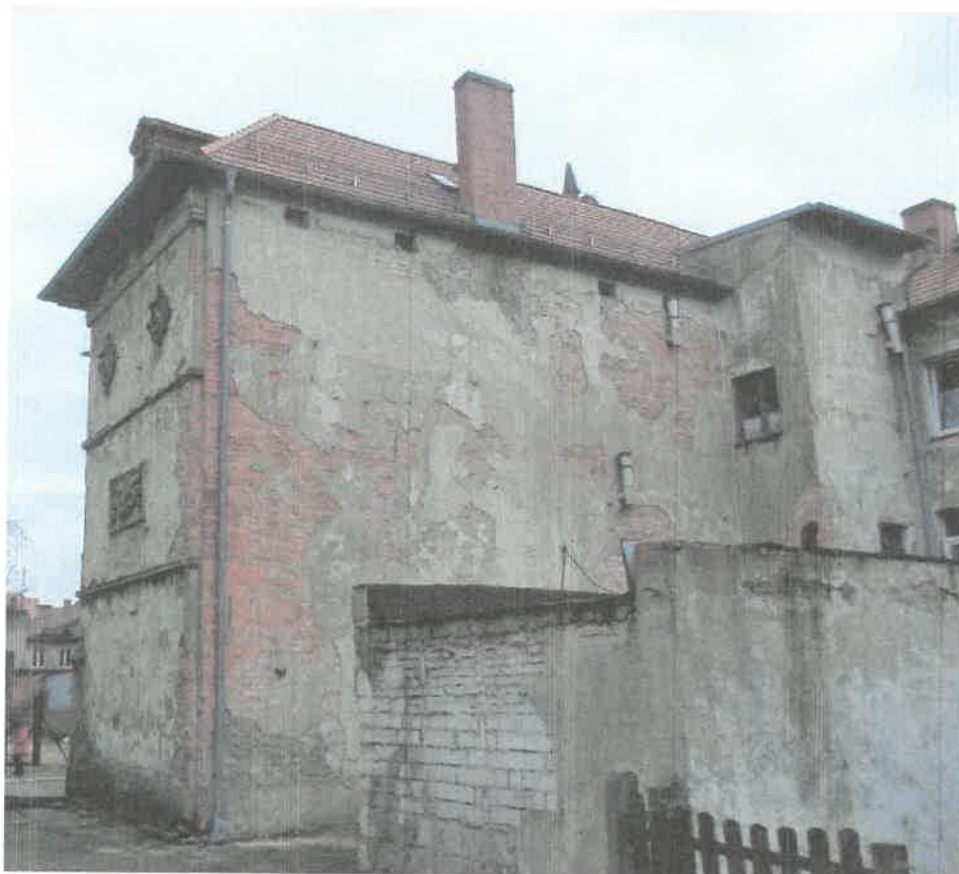
Zdjęcie nr 4 – Elewacja od strony podwórza
