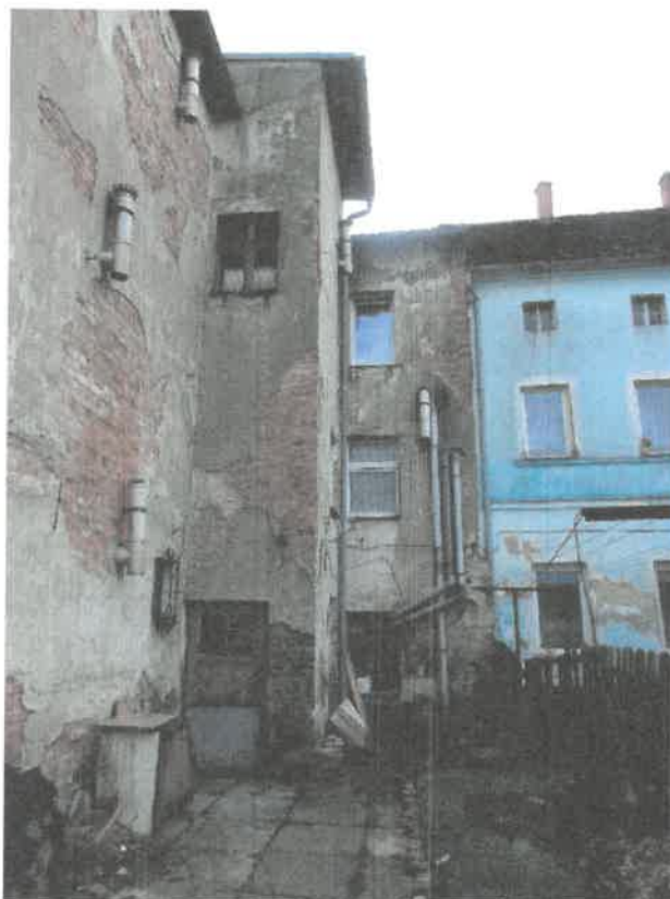
Zdjęcie nr 5 – Elewacja od strony podwórza
