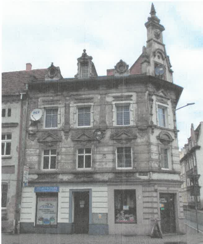
Zdjęcie nr 1 – Elewacja od strony ul. Legnickiej
