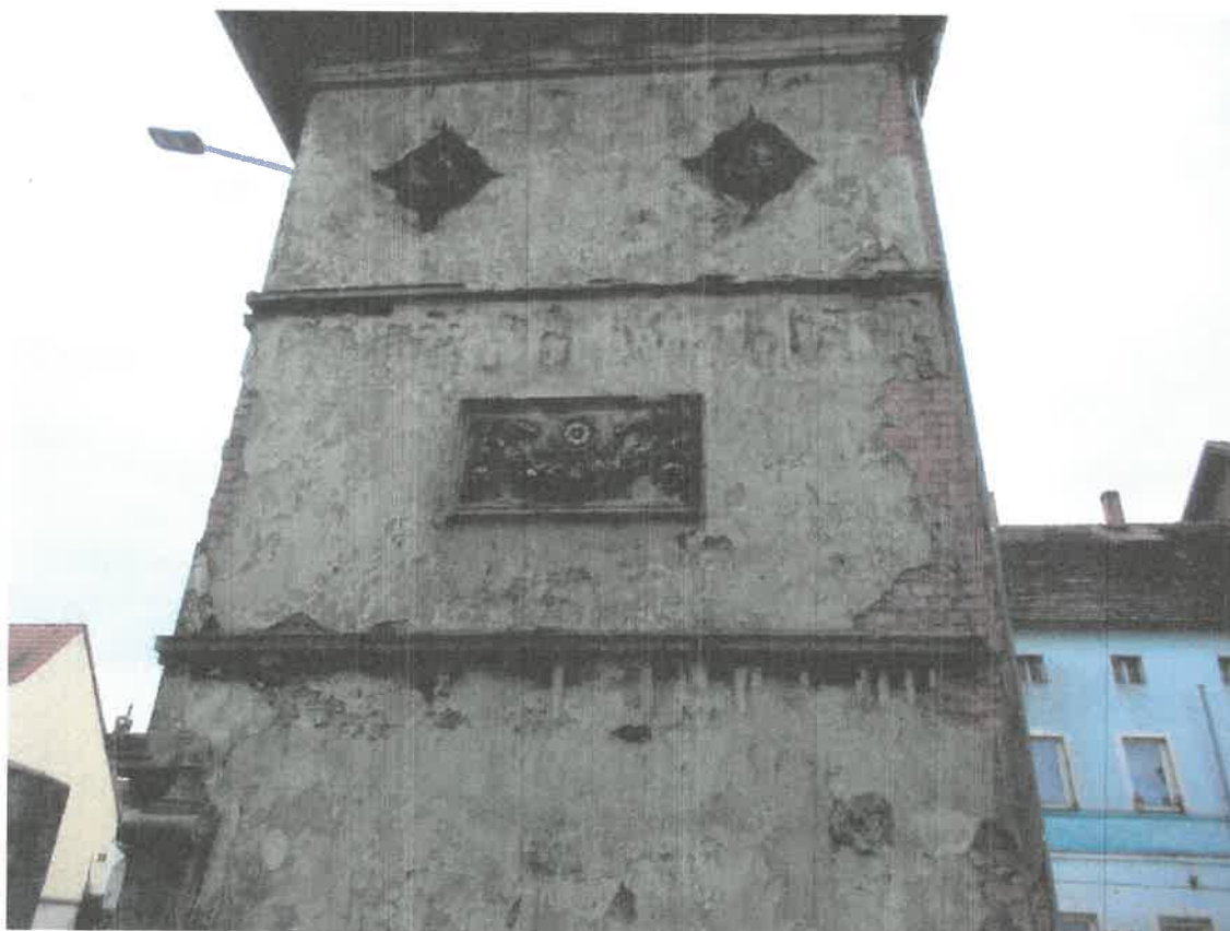
Zdjęcie nr 3 – Elewacja szczytowa
