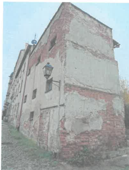
Widok elewacji szczytowej.
