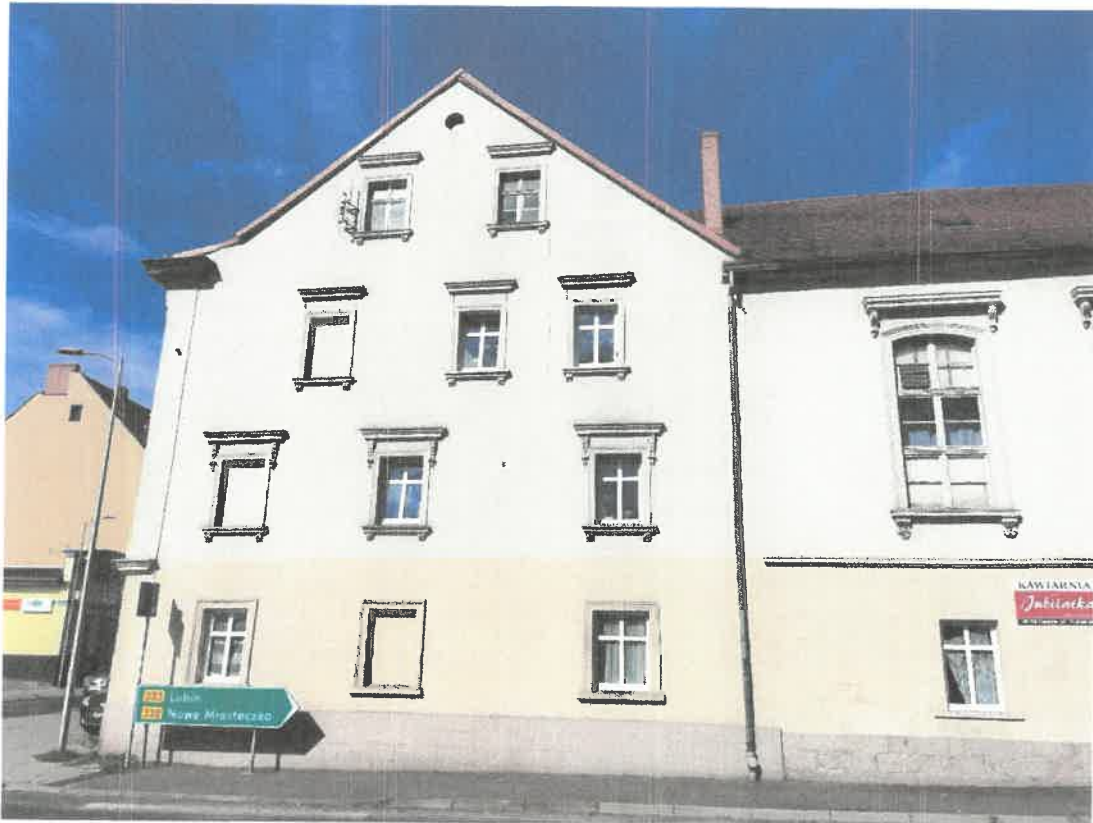
Zdjęcie nr 4 – Elewacja wschodnia
