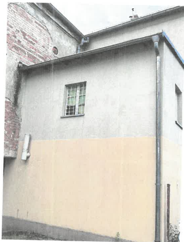
Zdjęcie nr 2 – Elewacja północna
