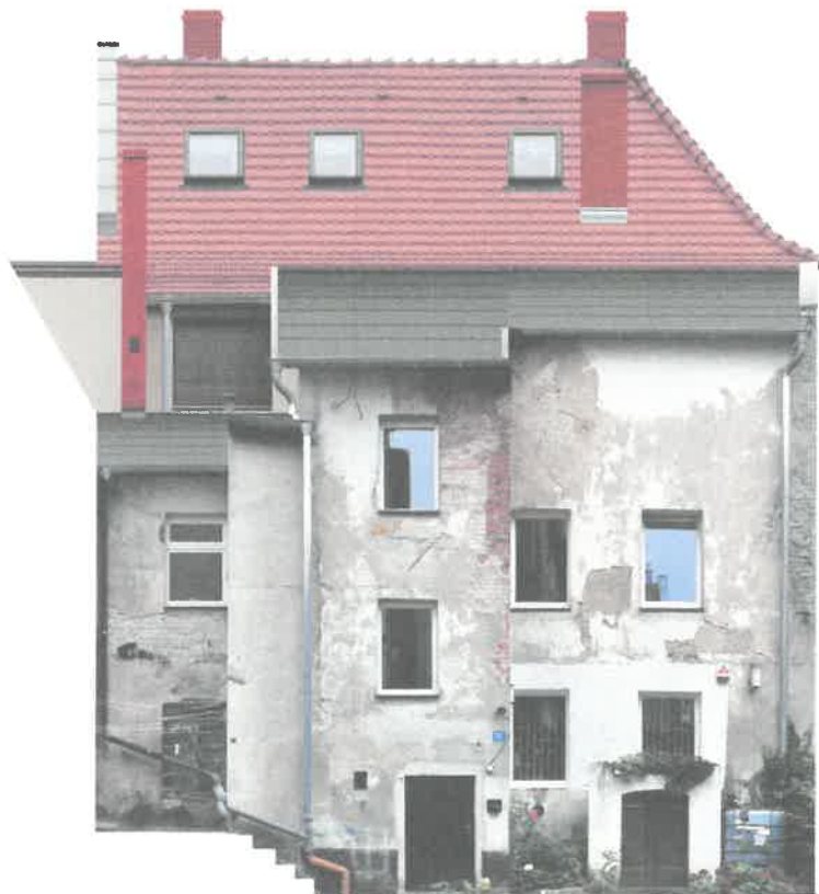
Widok elewacji podwórzowej.
