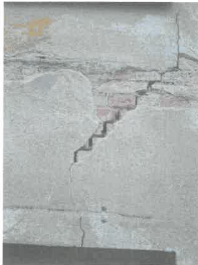
Zarysowania ściany podwórzowej między oknami poziomie I-go piętra klatki schodowej.
