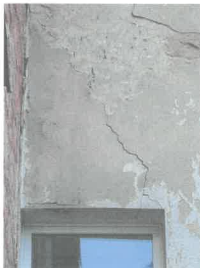
Zarysowania ściany podwórzowej między oknami poziomie I-go piętra klatki schodowej.
