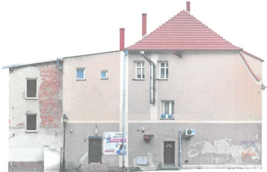
Widok elewacji szczytowej.
