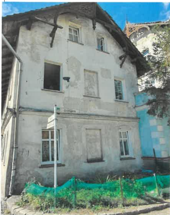
Zdj. nr 1 Elewacja wschodnia
