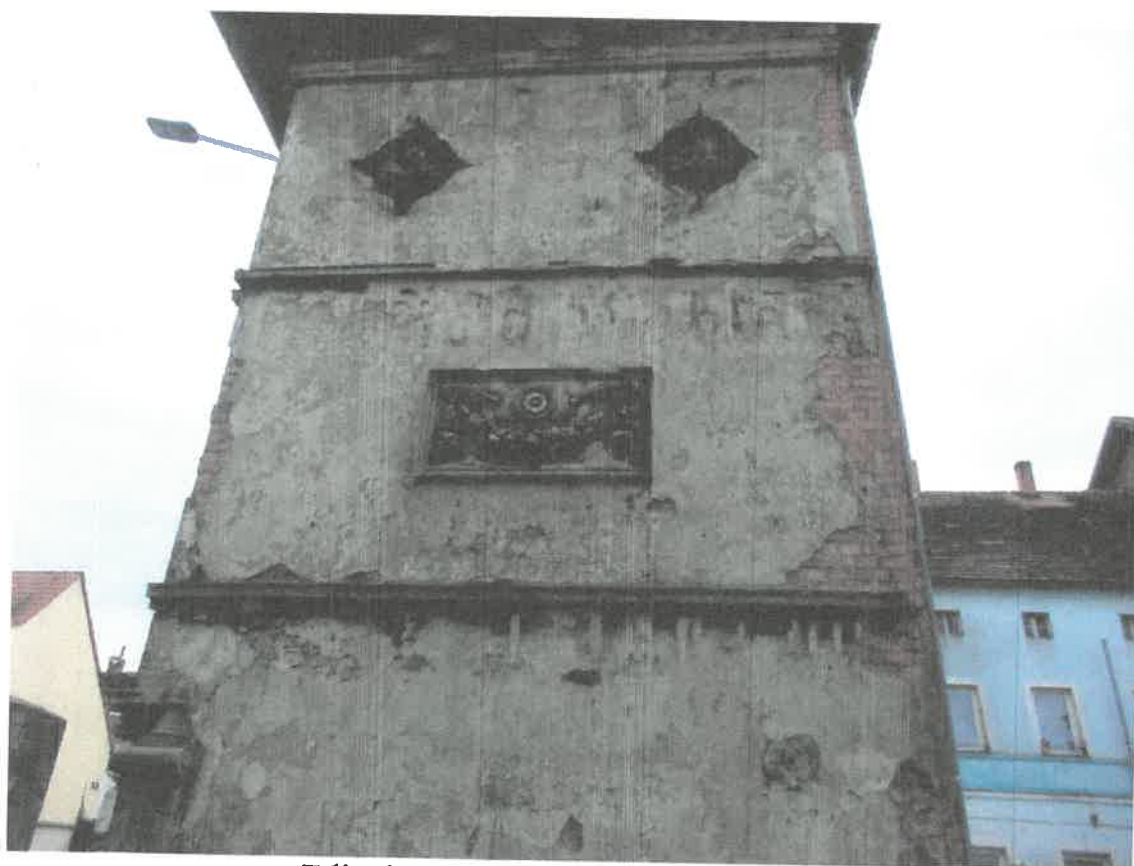
Zdjęcie nr 3 – Elewacja szczytowa
