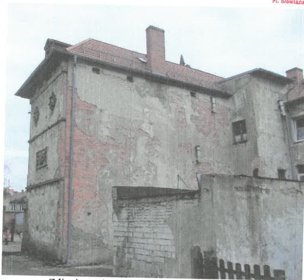
Zdjęcie nr 4 – Elewacja od strony podwórza
