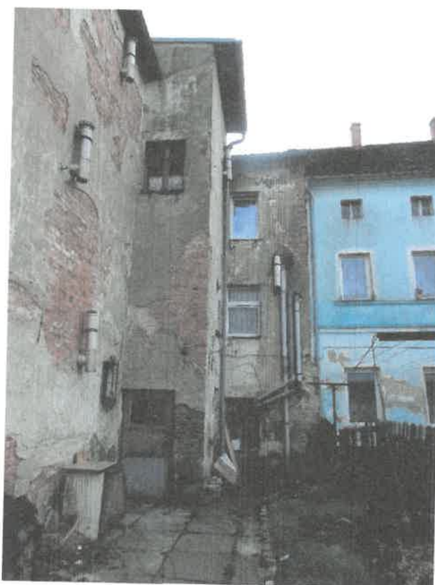
Zdjęcie nr 5 – Elewacja od strony podwórza
