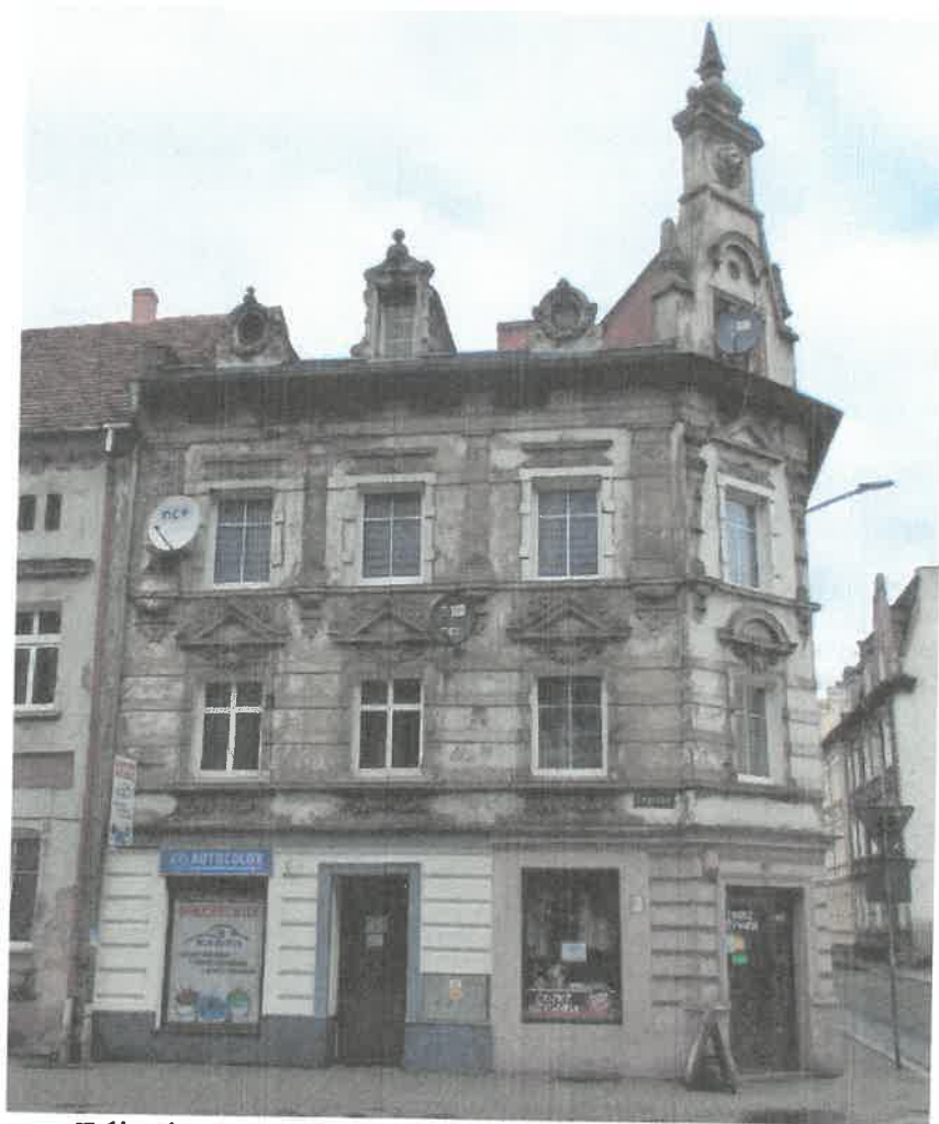
Zdjęcie nr 1 – Elewacja od strony ul. Legnickiej
