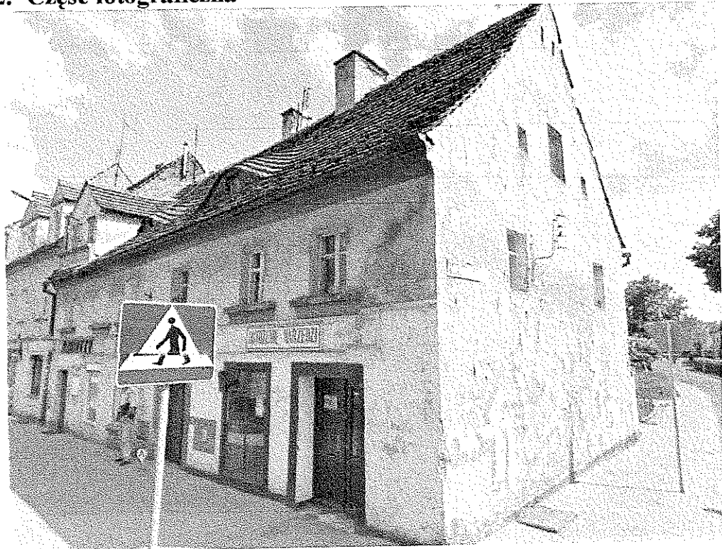
Zdjęcie nr 1 – Dach od strony ulicy
