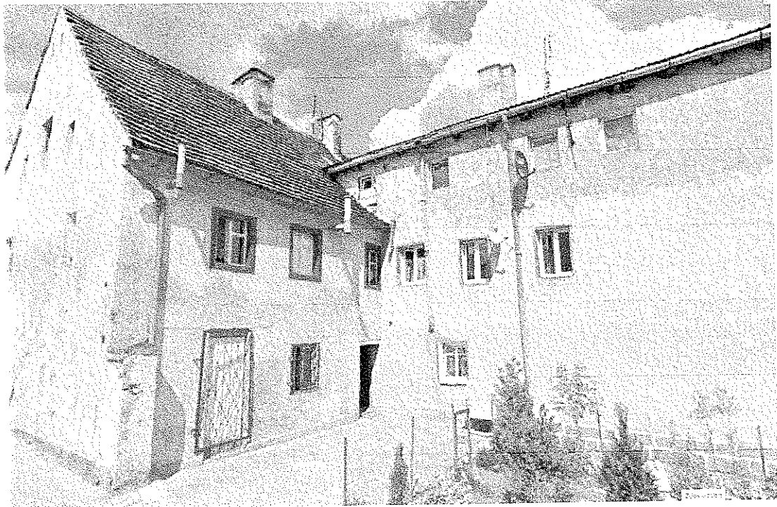
Zdjęcie nr 2 – Dach od strony podwórza
