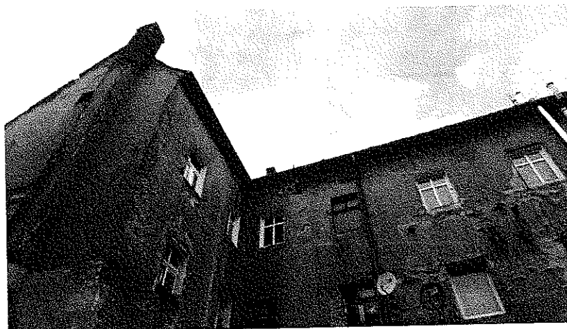
Zdjęcie nr 2 – Dach od strony podwórza
