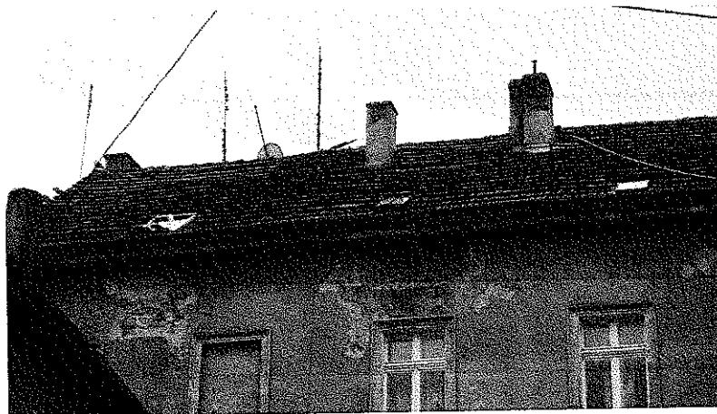
Zdjęcie nr 1 – Dach od strony ulicy
