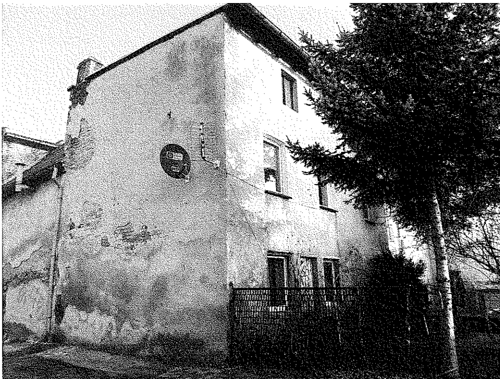
Zdjęcie nr 3 – Elewacja południowa
