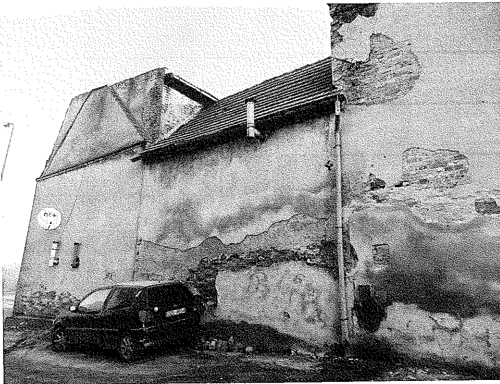
Zdjęcie nr 2 -- Elewacja zachodnia
