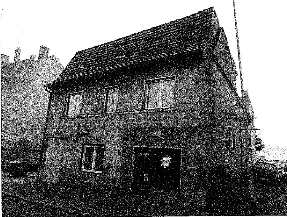
Zdjęcie nr 1 – Elewacja północna
