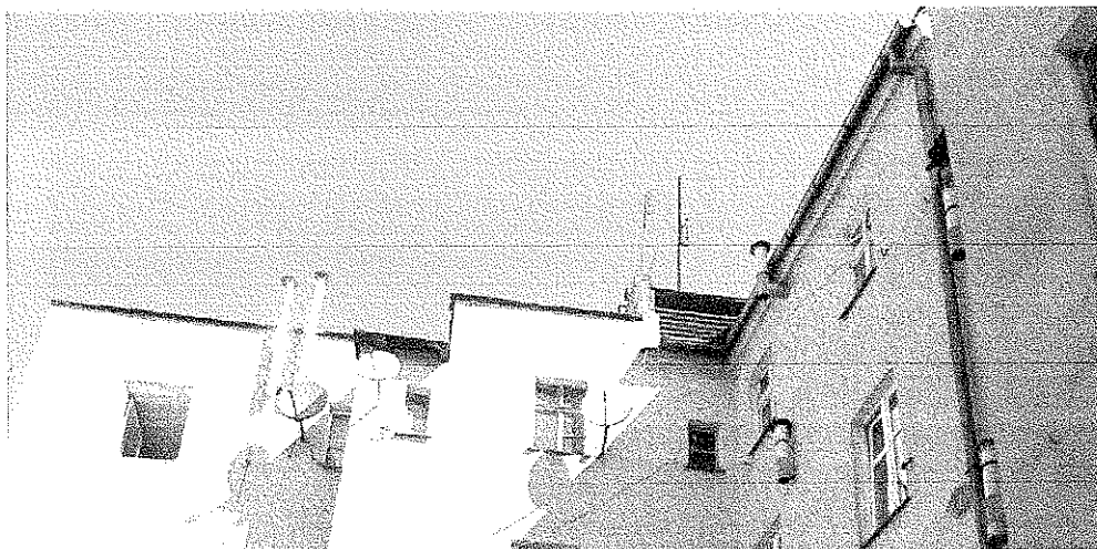
Zdjęcie nr 3 – Dach od strony podwórza
